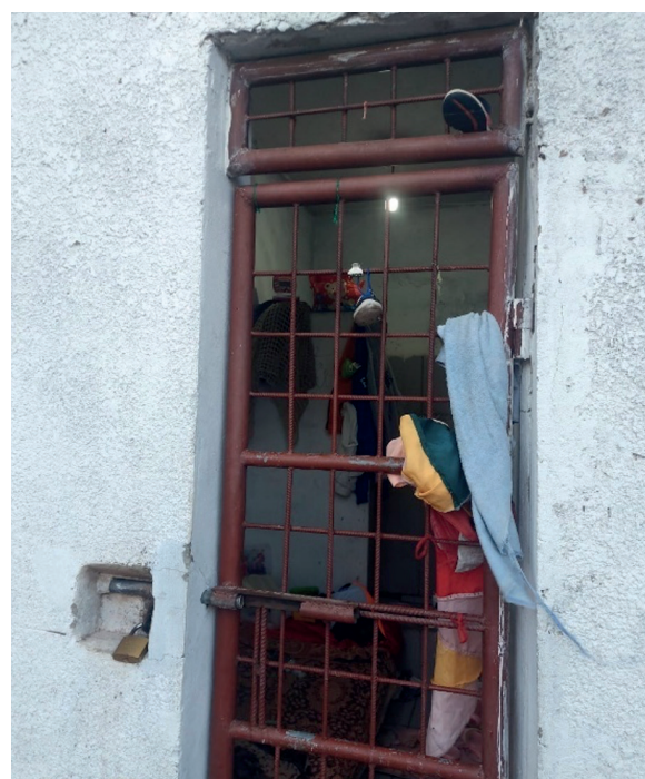
Celda de aislamiento PC2 (Mujeres)
