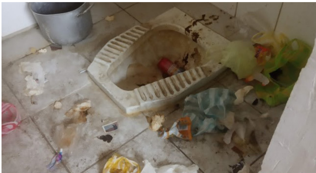
Baño de celda policial de varones de la Estación Policial Integral (EPI) "Patacón" (Sucre)
