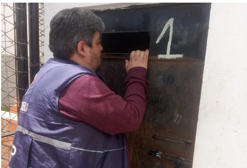
Entrevista a privados de libertad en celda de castigo del Centro Penitenciario de San Pedro de Chonchocoro, donde se evidencia que no existen ventanas que impiden una adecuada ventilación, ni el ingreso de luz natural y luz artificial. En los mejores casos sólo existe una ranura en la puerta.
