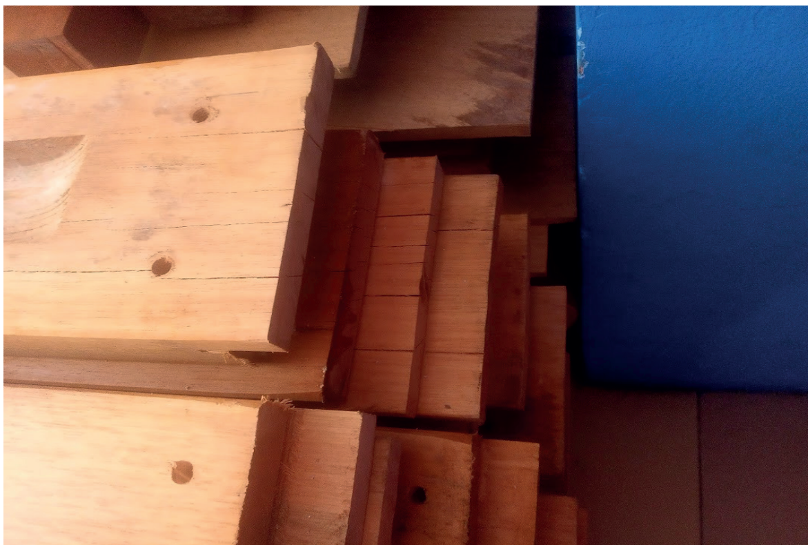
Madera de los catres "nuevos" con rajaduras
