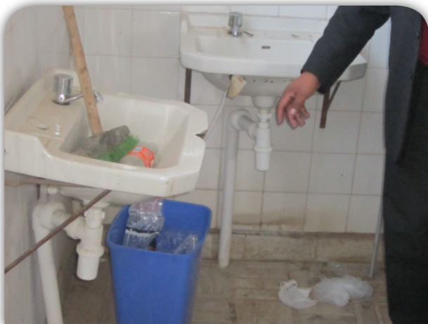
Interior de la Morgue en la ciudad de Oruro.
